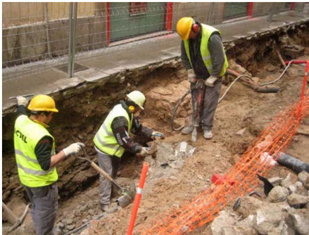
FOTO 5. Procés de destrucció del prisma de telefònica
