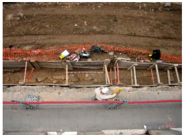
FOTO 32. Vista aèria del mur UE-40
