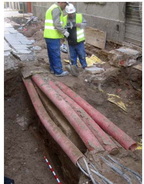
FOTO 48. Carrer Ferlandina, mur UE-67
