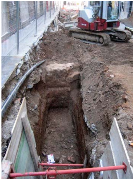
FOTO 29. Vista de detall del pou UE 43 i del mur UE 46
