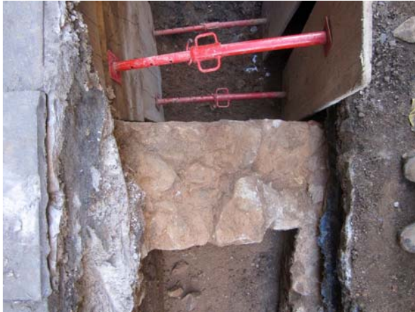
FOTO 37. Vista aèria del mur UE-63 i un tros del UE-64
