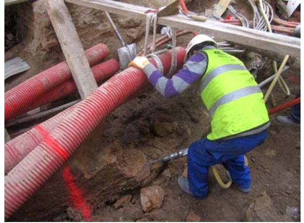
FOTO 50. Desmuntatge del mur UE 67
