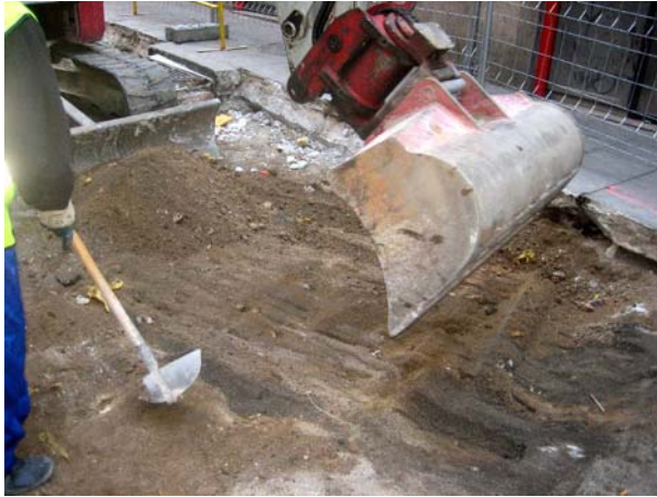
FOTO 1. Inici del rebaix mecànic
