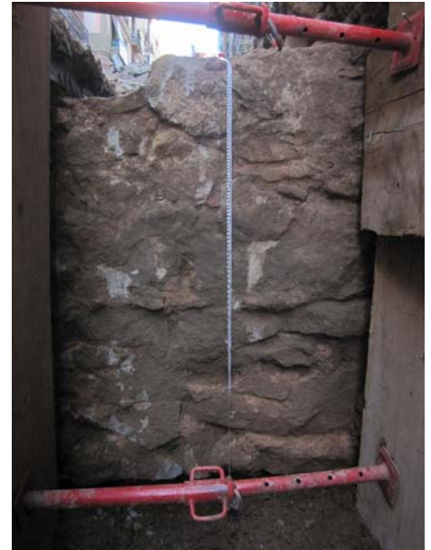
FOTO 38. Vista frontal de la cara SE del mur UE-63
