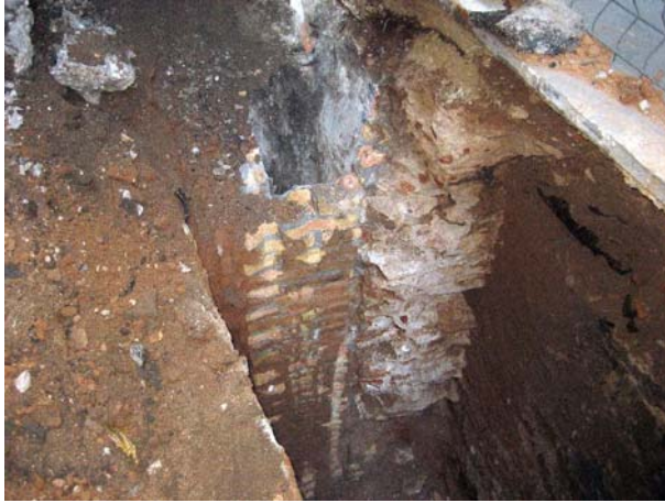
FOTO 45. Detall del tall del mur UE-64
