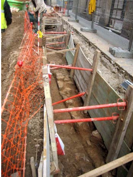
FOTO 33. Vista general del mur UE-40
