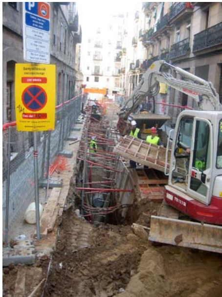
FOTO 7. Estat general de l'obra
