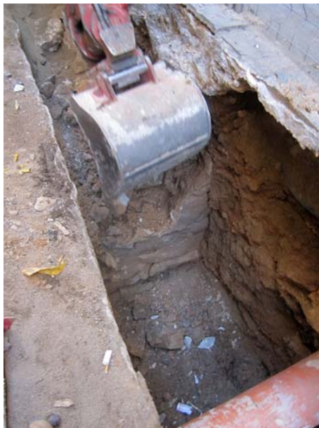
FOTO 39. Desmuntatge del mur UE 64
