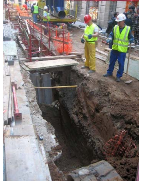
FOTO 6. Col·locació el tub RC2
