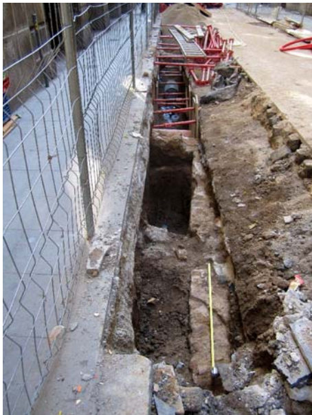
FOTO 35. Vista general dels murs UE-63 i UE-64
