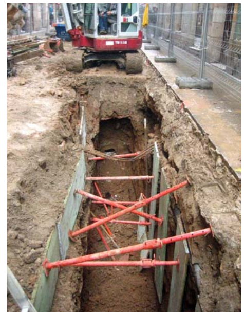
FOTO 4. Mesures de seguretat per mantenir la rasa oberta
