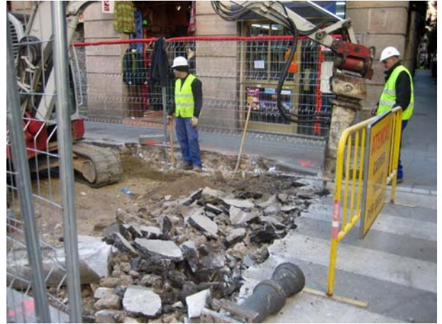
FOTO 2. Procés de repicat de l'asfalt
