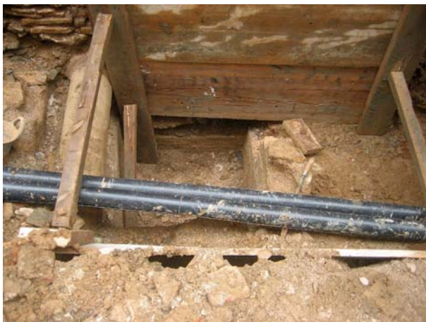
FOTO 23. Aturada d'excavació del dipòsit UE-09)
