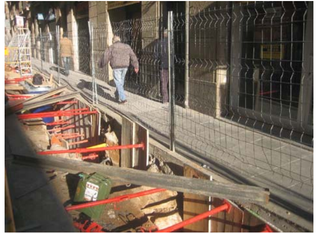
FOTO 42. Vista general de la rasa
